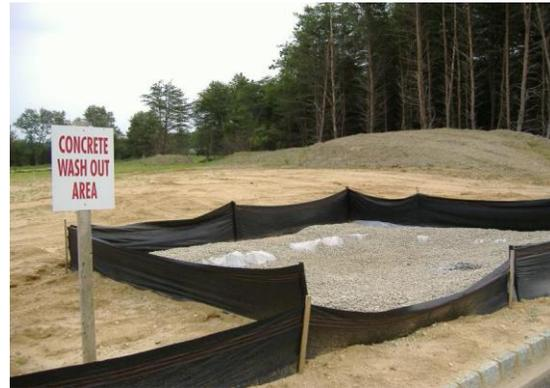
Hay diferentes tipos de instalaciones para lavado de hormigón disponibles y que pueden ser usadas en los lugares de construcción:
