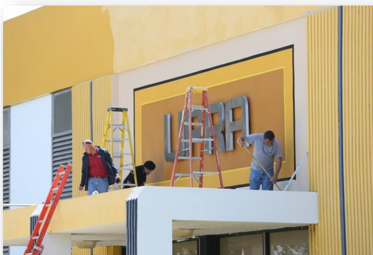
Instalación letras UPRA – Cancha de Baloncesto
